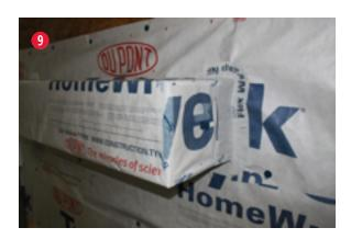
Tape all DuPont<sup>™</sup> Tyvek<sup>®</sup> WRB seams on cantilever using DuPont<sup>™</sup> Tyvek<sup>®</sup> Tape.
